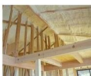
Per isolare e riempire giunti e cavità di costruzioni, allargamenti e isolamenti di tetti.
