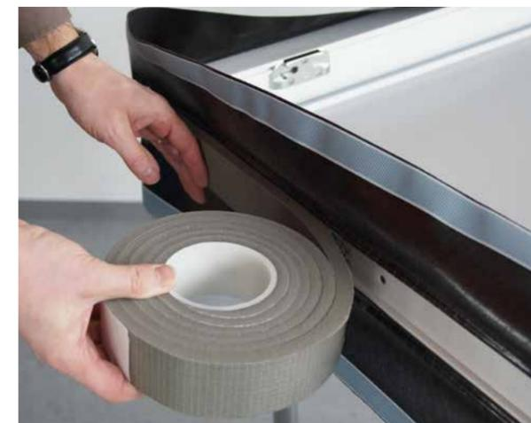
Il nastro isolante precompresso si monta intorno al telaio della finestra dove espande e chiude le fughe.
