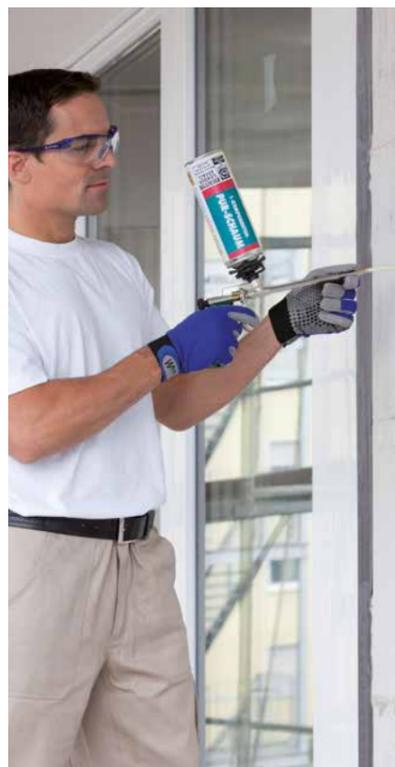
Nella posa di porte e finestre si usano schiume poliuretatiche flessibili per compensare l'espansione dei giunti.
