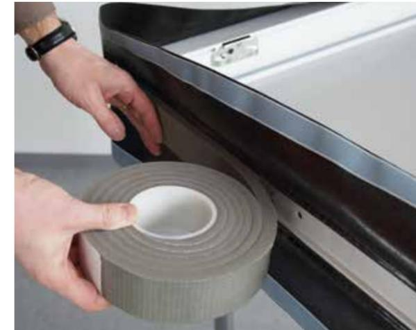
Das vorkomprimierte Band wird rund um den Fensterrahmen angebracht wo es expandiert
