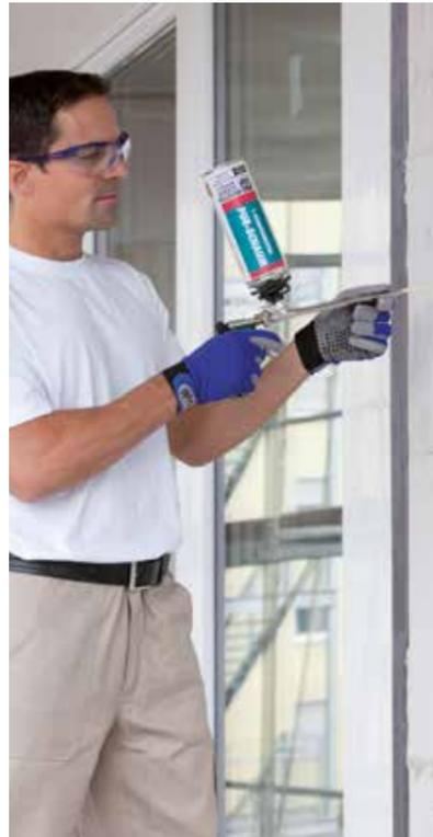
Im Tür- und Fenstereinbau werden flexible Bauschäume eingesetzt um Fugendehnungen auszugleichen.
