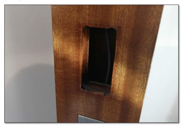
Infilare il cavo attraverso il foro fresato. Successivamente è possibile collegare il cavo dell'unità esterna con quello dell'unità interna all'interno dello scasso. Assicurarsi che l'unità interna non sia mai accessibile dall'esterno (per esempio estraendo i cavi).
